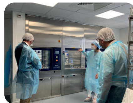
Mise aux normes de la stérilisation permettant de soutenir l'activité du bloc opératoire
