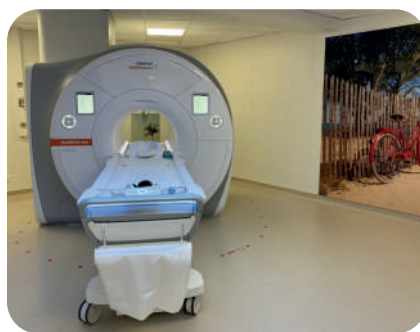
Réhabilitation du service d'imagerie et implantation de l'IRM
