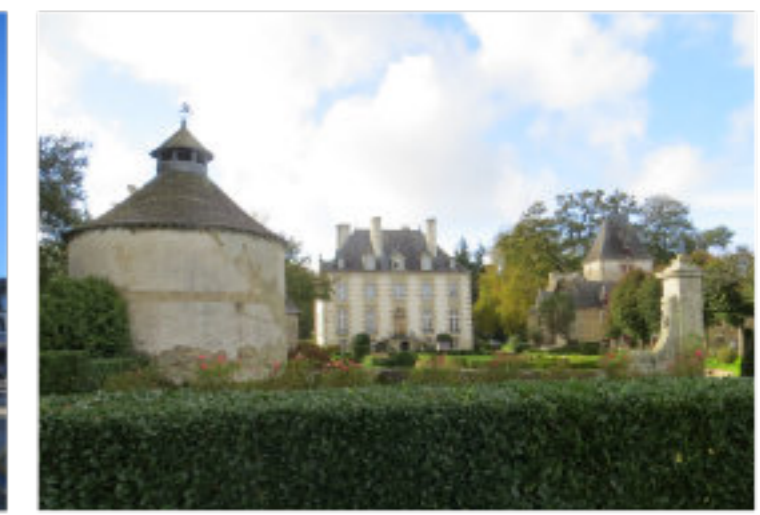
Château de la Haute Touche
