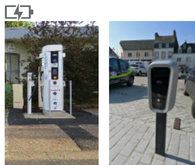
Bornes de recharge véhicules électriques
